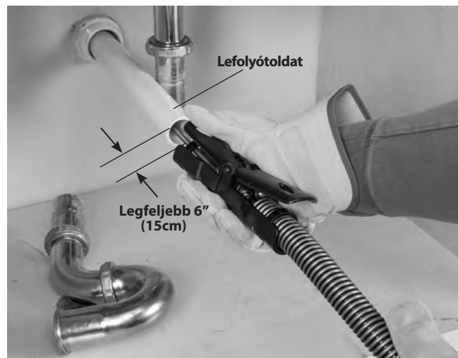
7. ábra – Példa a lefolyó torkolatának toldatára 6" (15 cm) távolságnál közelebbre az AUTOFEED egységtől.
