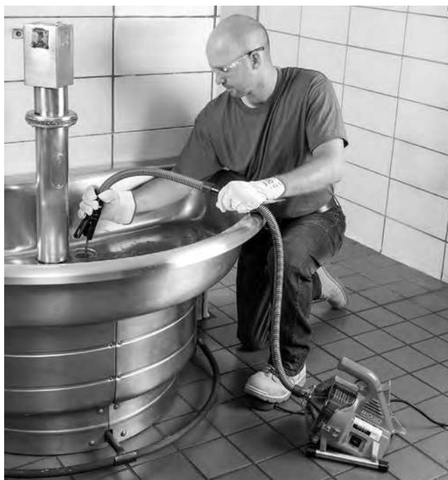
Рис. 11 – Извлечение троса
