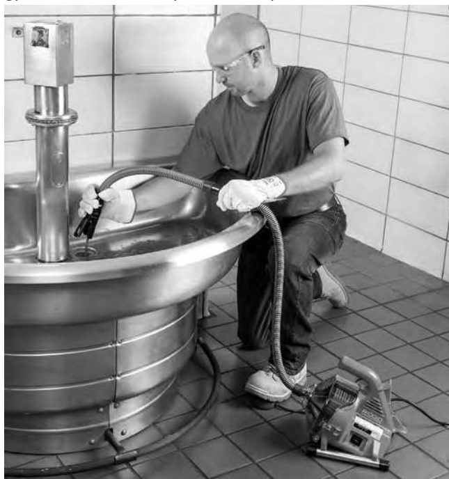
11. ábra – A kábel kihúzása
