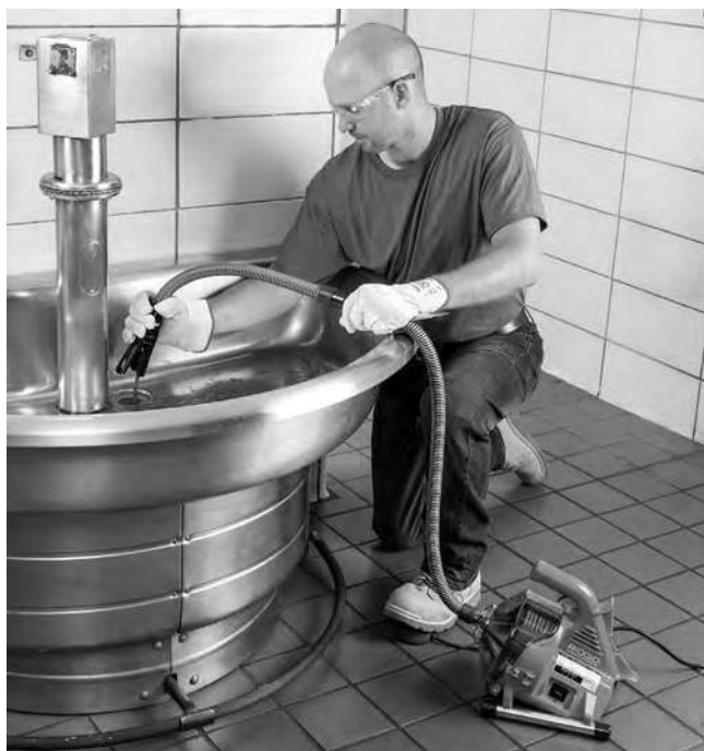
Figur 11 – Trekke ut kabelen
