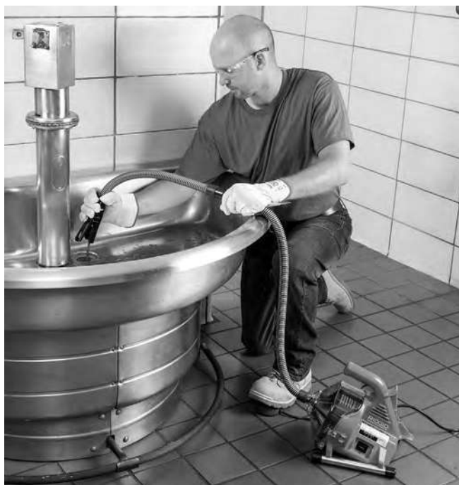
Figura 11 – Recupero del Cavo
