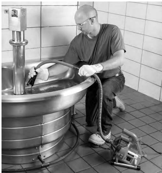
Slika 11 - Povlačenje sajle
