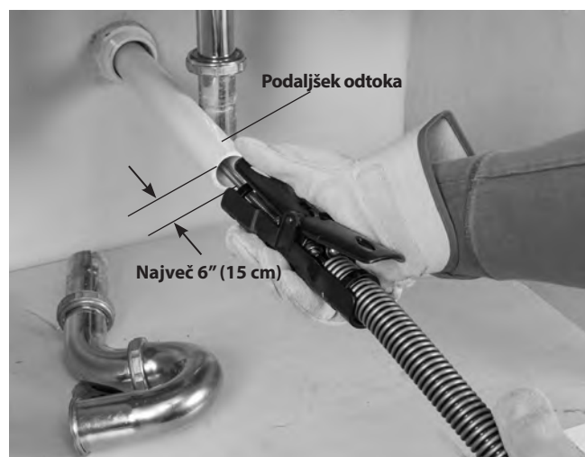
Slika 7 – Primer podaljšanja odtoka do 6" (15 cm) za enoto podajalnika AUTOFEED.
