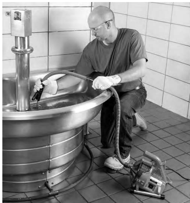
Obrázek 11 – Vytažení kabelu
