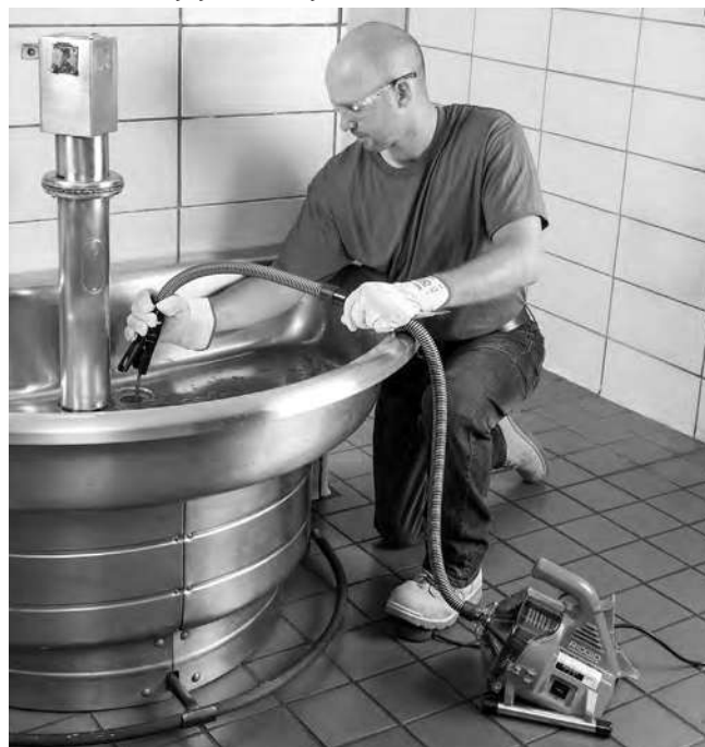
Slika 11 – Izvlak kabla
