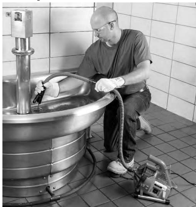
Abbildung 11 – Zurückziehen der Spirale
