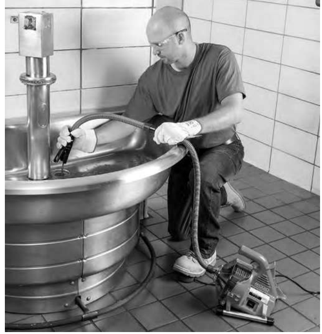
Şekil 11 – Kablonun Geri Toplanması
