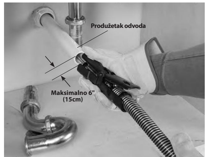
Slika 7 - Primjer produžetka odvoda na udaljenost manju od 6" (15 cm) od AUTOFEED uređaja.
