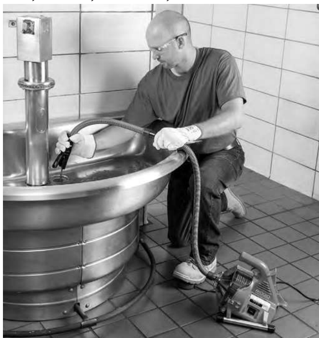
Figura 11 – Retragera cablului
