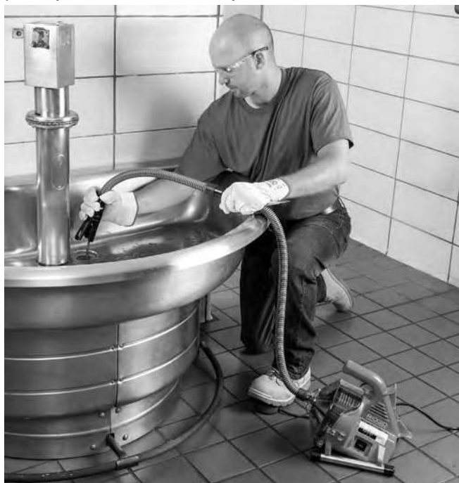
Slika 11 – Izvlačenje sajle
